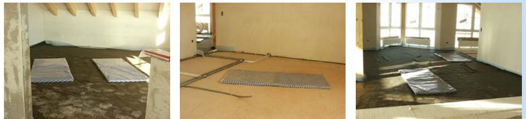
Die Matten können Richtungsunabhängig verlegt werden, sind wartungsfrei, aber bei Einbau nochmals mit einer Folie vor dem nassen Estrich abzudecken. Die Abschirmung muss Etage für Etage vorgenommen werden, abgesehen von selten genutzten Kellerräumen.
