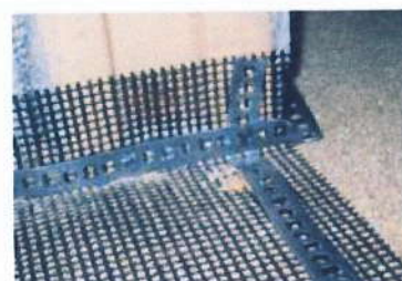
Erdung mittels Lochband
